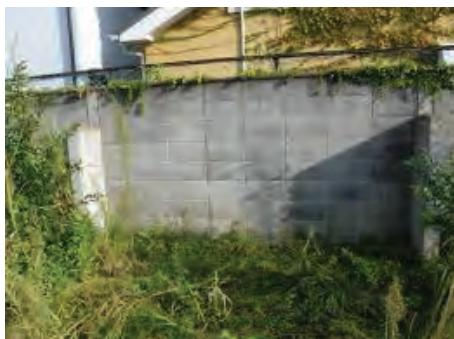
外観から「組積造」と「補強コンクリートブロック造」の見分けがつきにくい
